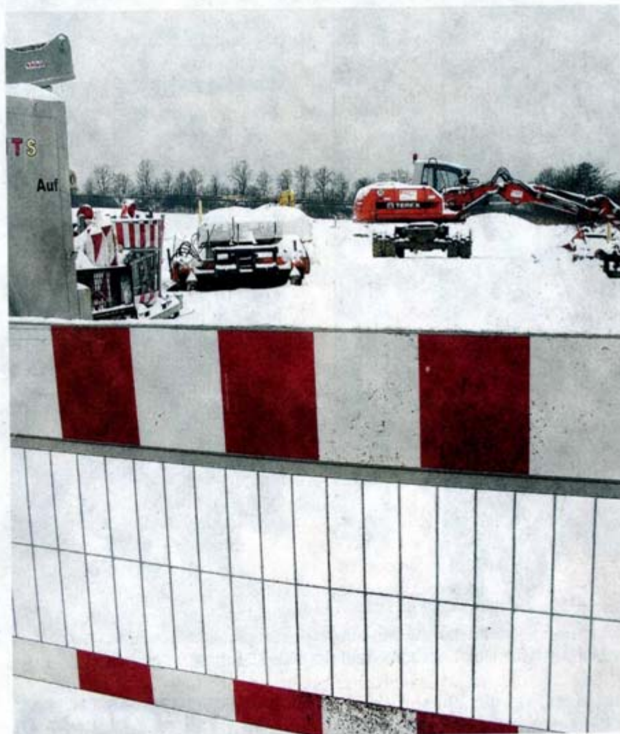
Schnee stoppt derzeit den Straßenbau für die Grundstückserschließung. Bald soll Spatenstich sein im Gewerbepark Weinsberg/Ellhofen am Autobahnkreuz.
